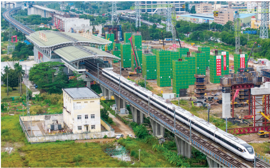
深江铁路中山北站施工现场。
