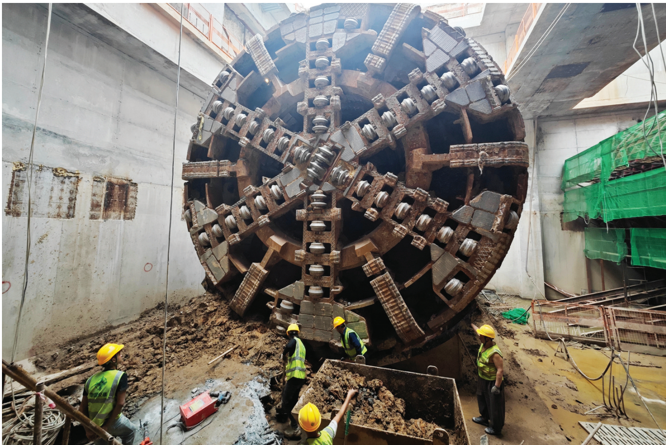
南中城际石岐站至岐江新城站左线盾构区间已经实现贯通。工人正在清理盾构刀片前的渣土。
